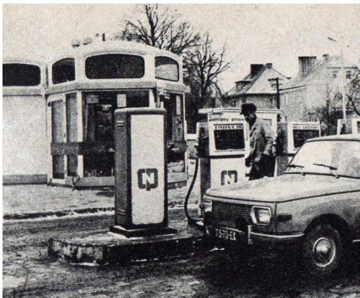
Pierwsza w Polsce stacja benzynowa w Człuchowie, wykonana kompleksowo z prefabrykatów (tworzyw sztucznych) 17
