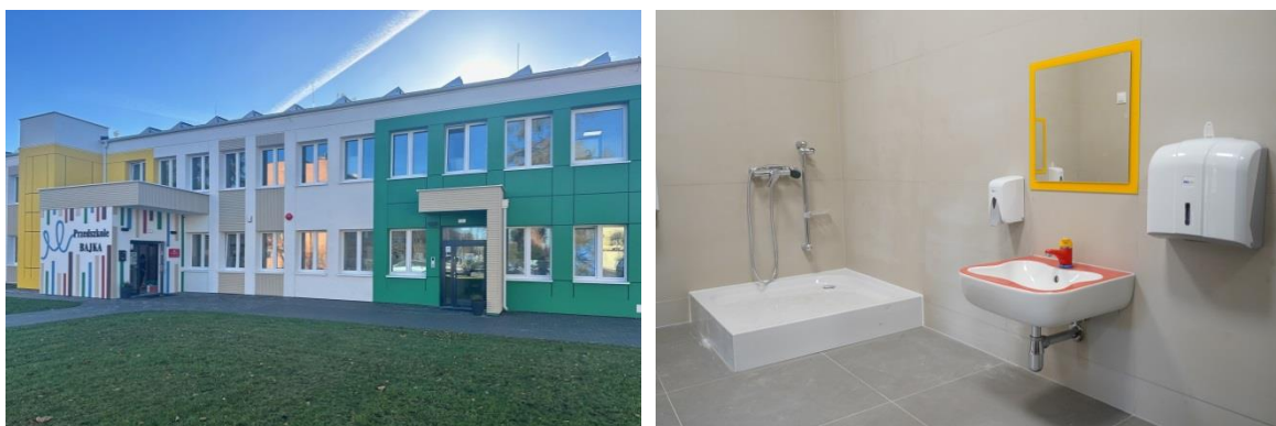
Fot. 5 i 6. Przebudowa i rozbudowa istniejącego budynku na przedszkole i żłobek.
