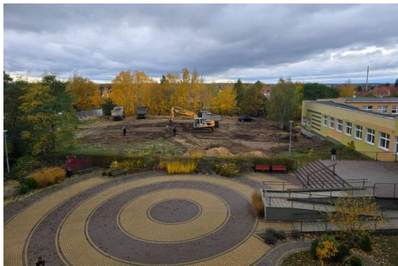
Fot. 9, 10, 11 i 12. Prace ziemne przy budowie i konstrukcja nowego boiska wielofunkcyjnego przy SP nr 1.
